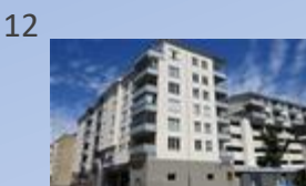
12 Brf Järnvägsparken, 640 st, 2006
