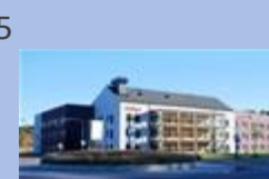
5 Kv Älvängen, 187 st, 2016
