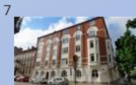
7 Kv Påskalyckan, 143 st, 2015
