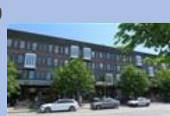
9 Kv Bytarebacken, 462 st, 2014
