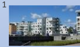
Brf Strandkanalen, 612 st, 2016
