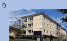
9 Brf Enköpingshus, 230 st, 2011
