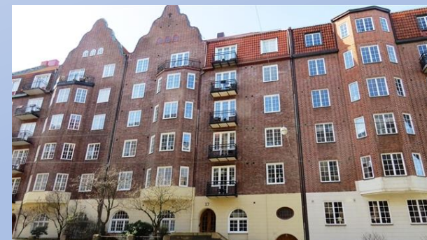
Aschebergsgatan 27 (Brf Ingeborg Louise)
