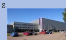
Kv Ismåsen, 84 st, 2009
