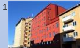
1 Kv Nordstjärnan, 214 st, 2017
