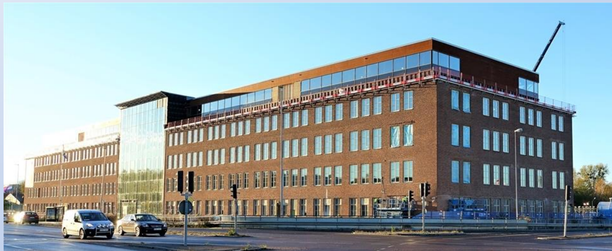
Foto efter fönsterbyte
