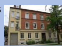
6 Kv Pelikanen, 34 st, 2006
