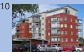
10 Kv Läraren, 240 st, 2004
