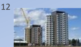
Brf Sandåkern, 662 st, 2013
